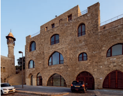
01 Die Zufahrt zum Gebäudekomplex – das Garagentor lässt sich mit Fernbedienung öffnen.
