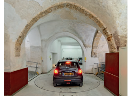
03 Die fast tausend Jahre alte Bausubstanz, die dem Denkmalschutz unterliegt, bedingt die Technik. Rangierflächen sind knapp, deshalb helfen Drehplatte 505 und Verschiebepalette 504 die Fahrzeuge so zu positionieren, dass die Stellplätze genutzt werden können.
