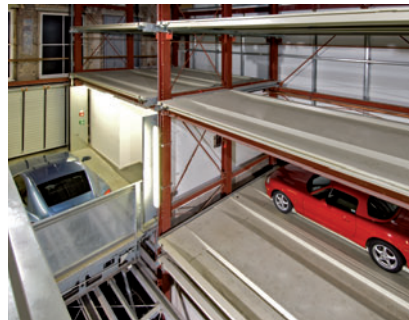
15 Mit gleichzeitigen X, Y Bewegungen (Vertikallift/ Shuttle) erreicht die belegte Parkpalette die Übergabekabine Ausfahrt. Sehr gut zu sehen ist auch die rückwärtige Absicherung am Shuttle, um den Zugang zum Arbeitsbereich zu verhindern. With simultaneous X and Y movements (vertical lift / shuttle) the occupied parking pallet reaches the exit area. Very good to see is also the rearward securing on the shuttle, to prevent access to the work area.
