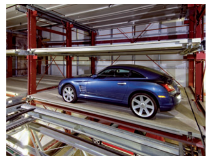
09 Sobald die Parkposition erreicht ist, entkoppelt sich das Shuttle von der Parkpalette.
