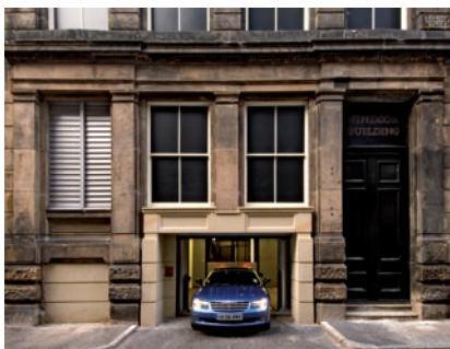
16 Durch die denkmalgeschützte Außenfassade verlässt der Nutzer den Parksafe 583. The driver departs from the Parksafe 583 through the preserved historical façade.
