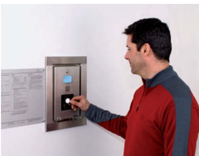
10 Zur Ausfahrt wählt der Fahrer seinen Pkw im Warteraum berührungslos mit seinem Transponder an.
