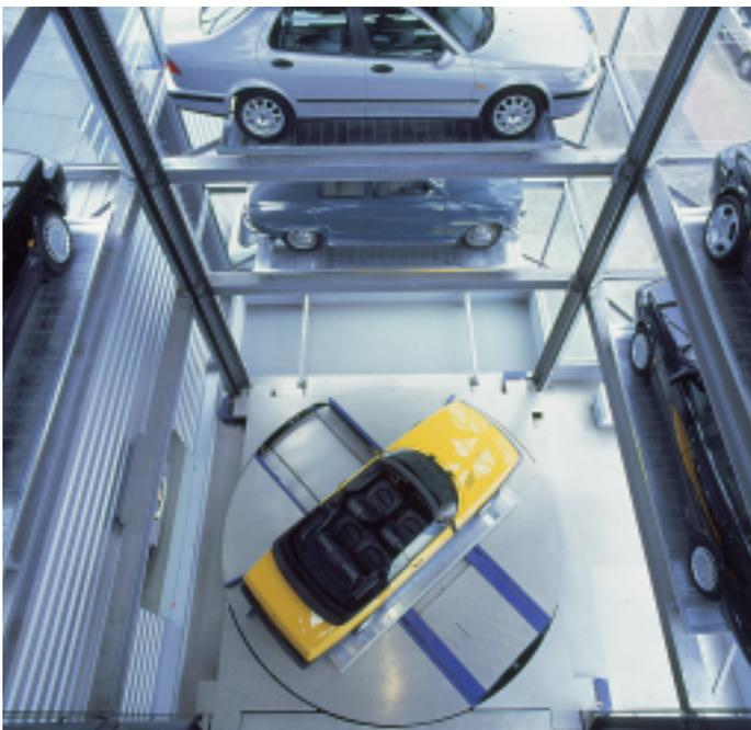
Auf der integrierten Drehscheibe wird das Fahrzeug in die zum Einlagern oder zum Ausfahren gewünschte Position gebracht.
